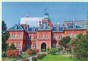
かつて解体の危機にあった 北海道旧本庁舎
