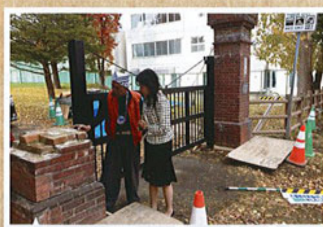
2019年10月 工事開始 現場にて進捗状況を伺う
